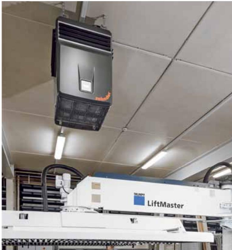
**CleanAir-6-Luftreiniger, installiert über einer Trumph-Maschine in einer Produktionshalle.**
